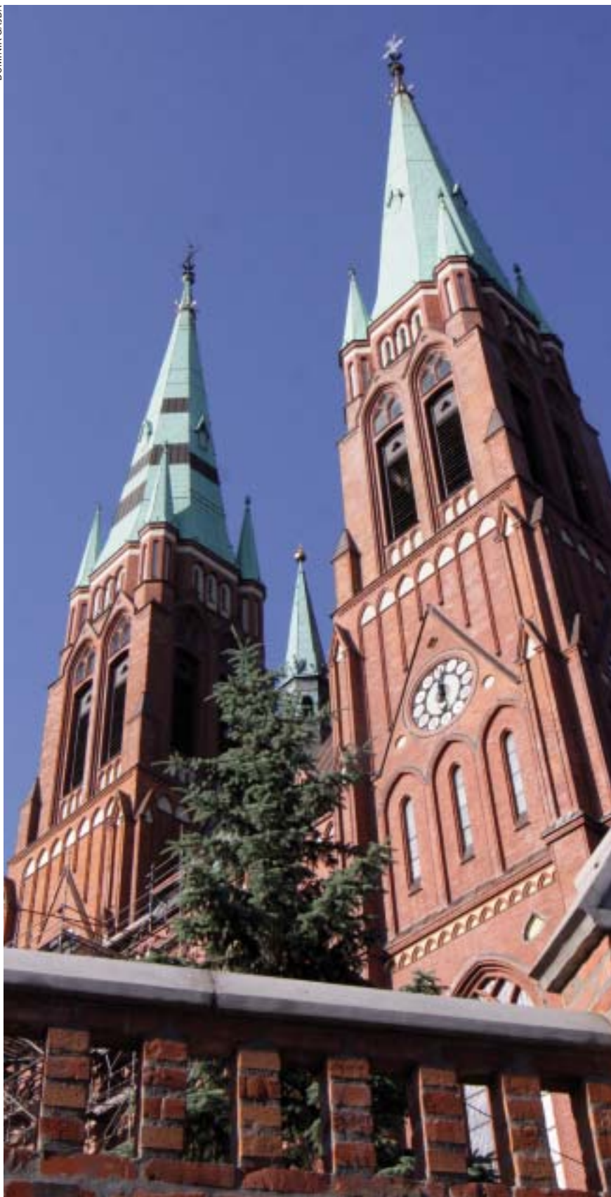
Bazylika św. Antoniego w Rybniku. Uszkodzona w wyniku wybuchu amunicji na stacji kolejowej
